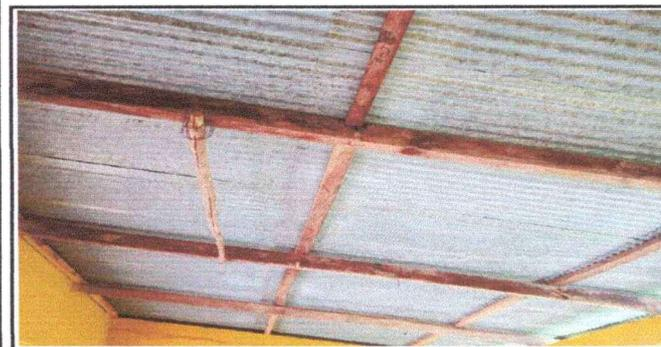
Foto 5: Sustrucción de costaneras de madera a metal
